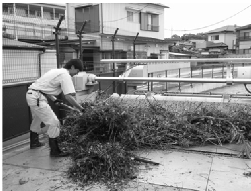
除塵機のゴミの状況
