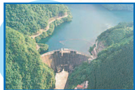
荒川の上流にある二瀬ダム
